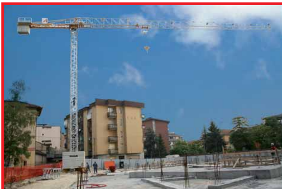
Completamento dello zavorramento. Counterweight completion.
