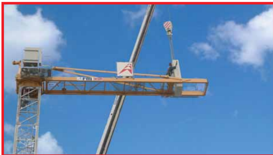
Parziale zavorramento. Partial ballasting.
